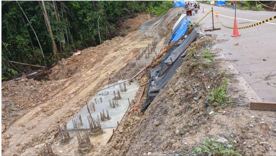
Lampiran 4 Kondisi Bahu jalan dan pesebaran titik bor dan Lantai kerja
