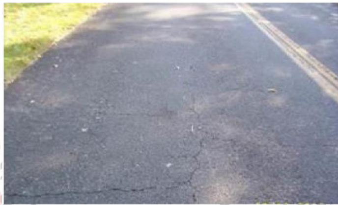
Gambar 2. 3 Retak Blok (Kementrian PUPR 2017:6)
