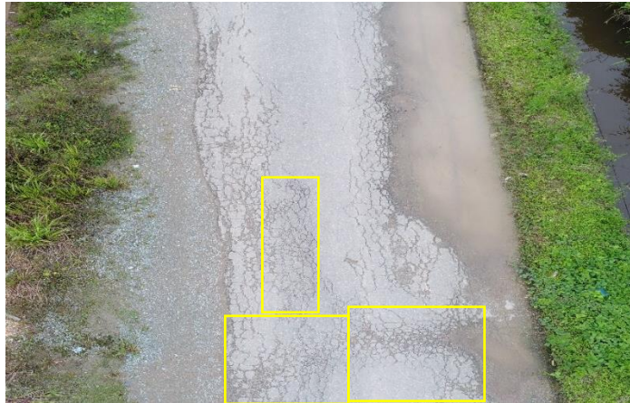
Gambar 2. 10 Alligator Crack (Dokumen Pribadi)
