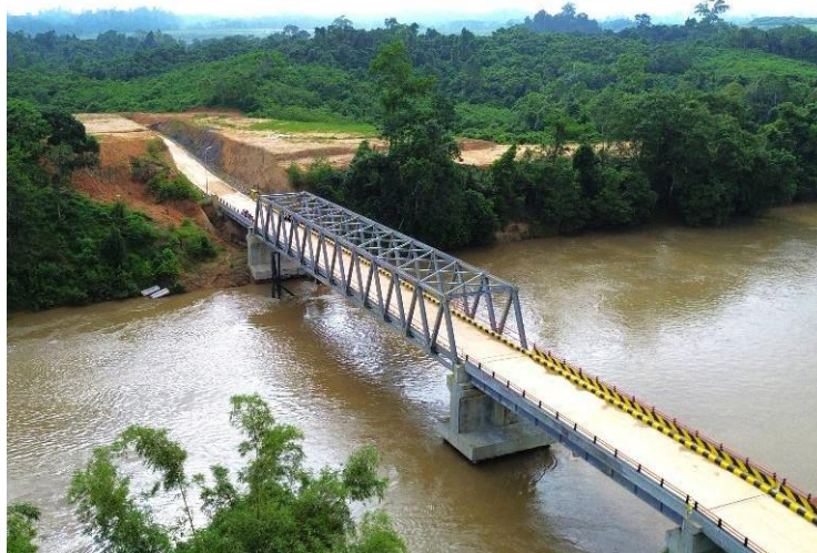
Gambar 2. 1 Contoh Jembatan Rangka (Sumber: Foto udara 2025)
