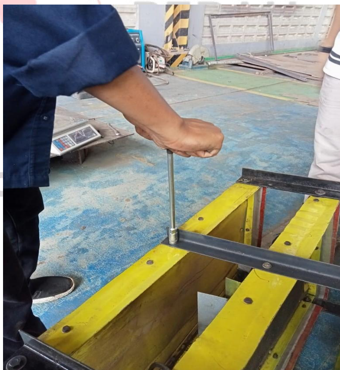
Perakitan Bak Saringan
