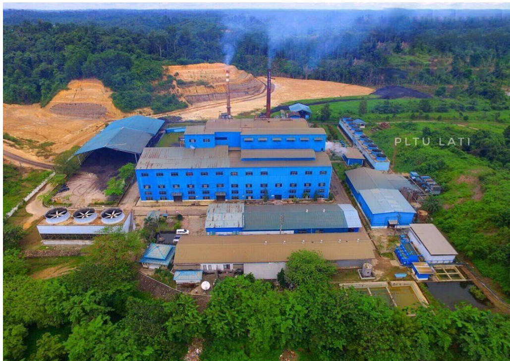
Gambar 3. 1 PLTU Site Lati
