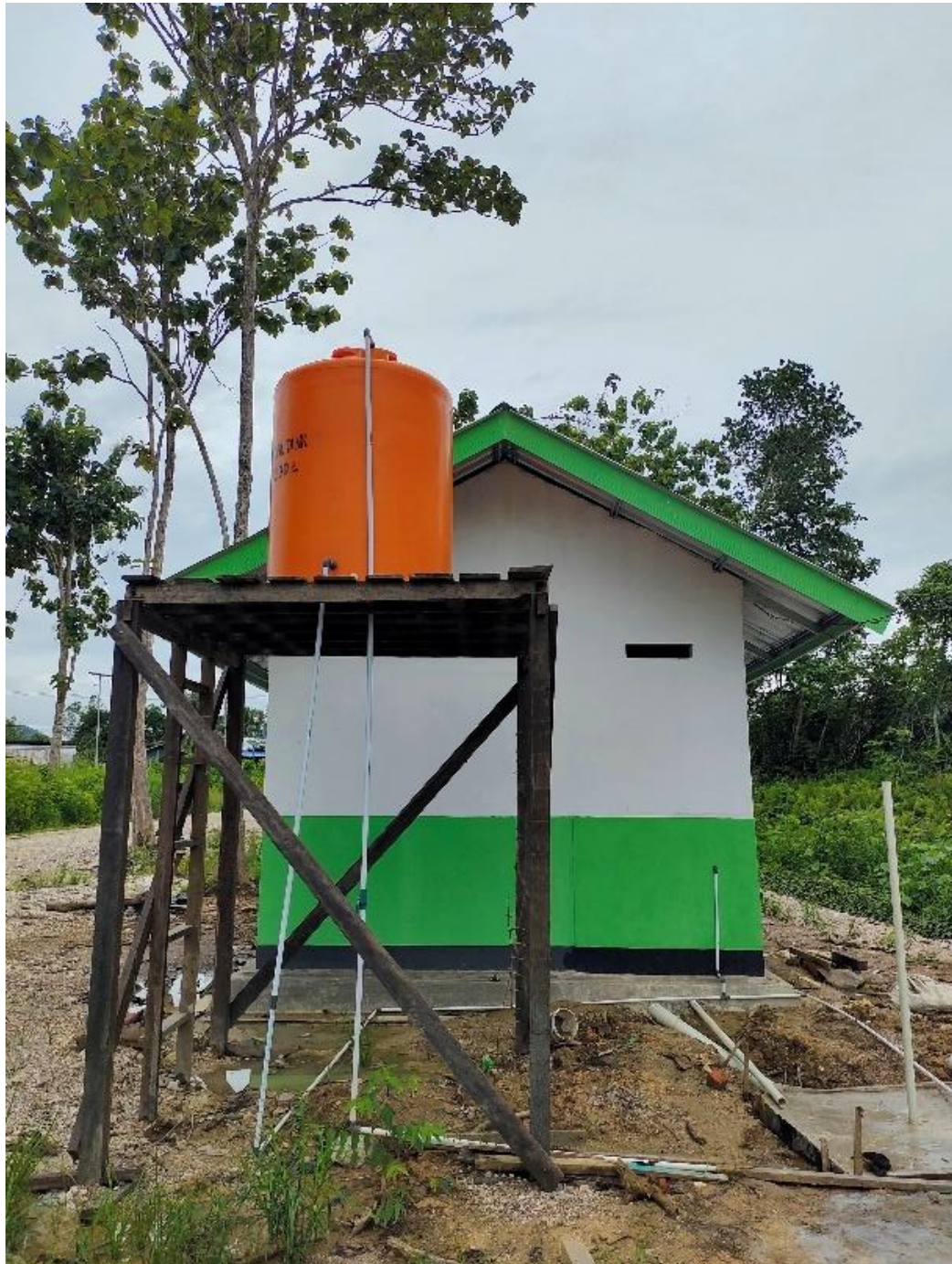
Lampiran 14 Tampak Belakang Balai Pertemuan
