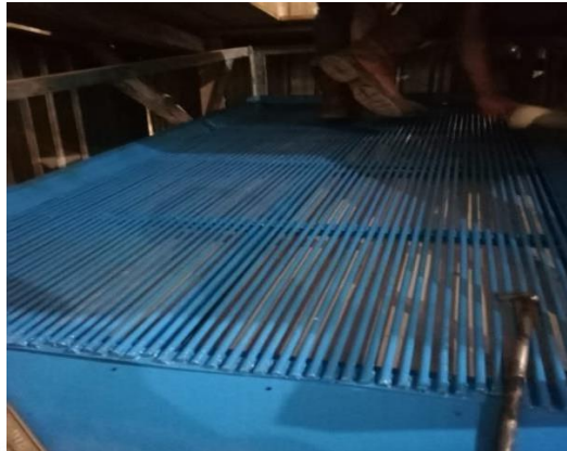
Lampiran 12 Pemasangan Screen Sortasi Layer 2
