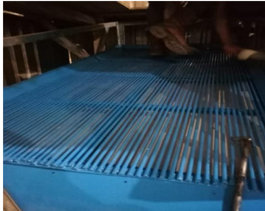
Lampiran 12 Pemasangan Screen Sortasi Layer 2
