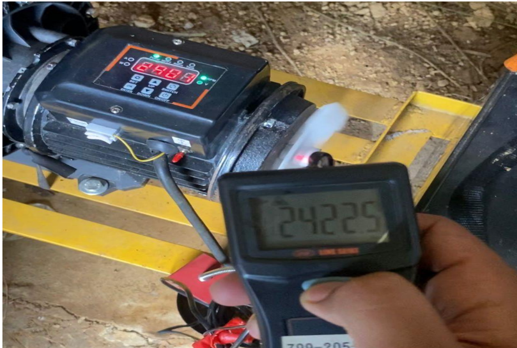
Proses Pengukuran RPM Pompa Menggunakan Tachometer
