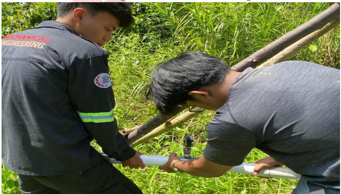
Pemasangan Alat Ukur Tekanan Hisap
