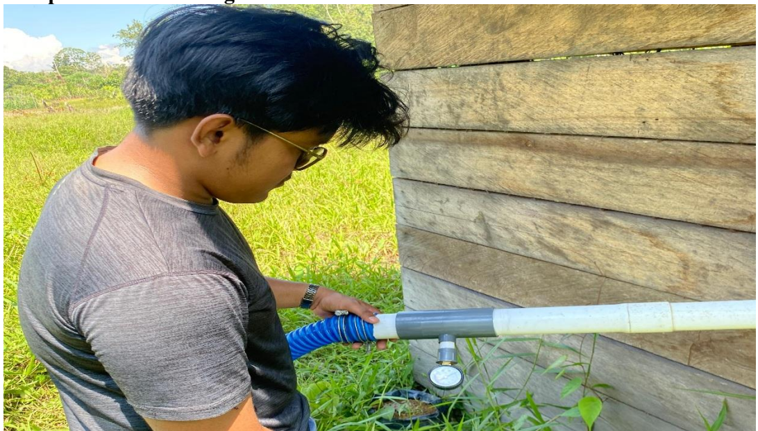
Pemasangan Alat Ukur Tekanan Buang
