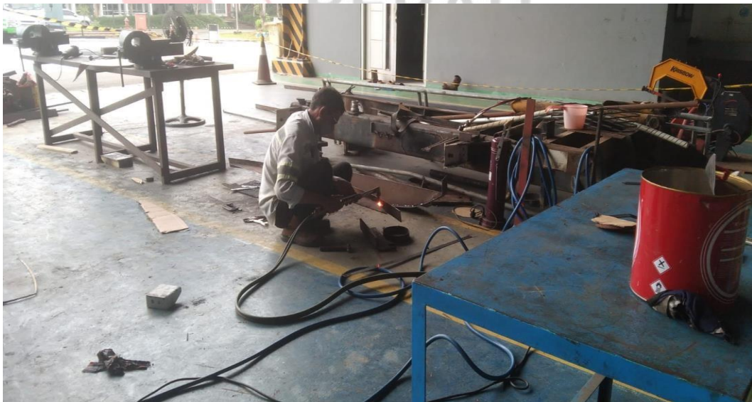
Penyesuaian ukuran besi
