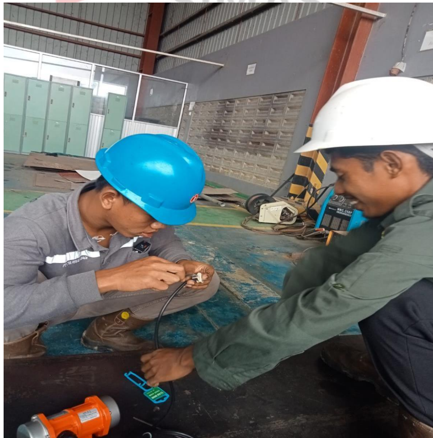
Gambar. Penyambungan Kabel
