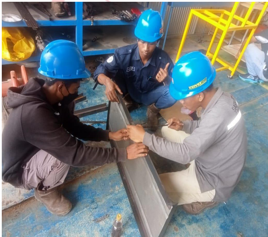
Gambar. Pemasangan Baut
