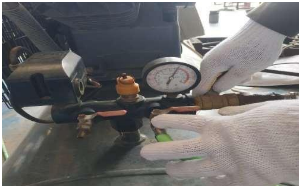
Lampiran 1. 5 Pengecekan tekanan pada kompresor
