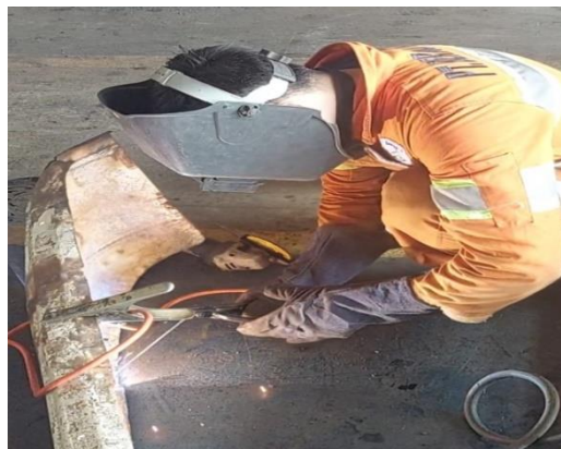
Gambar 2.5 Posisi Pengelasan Tegak (Vertikal) Sumber : Dokumentasi pribadi 2023
