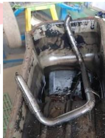
Gambar 2.28 Oil Strainer Sumber: Dokumentasi Pribadi 2023
