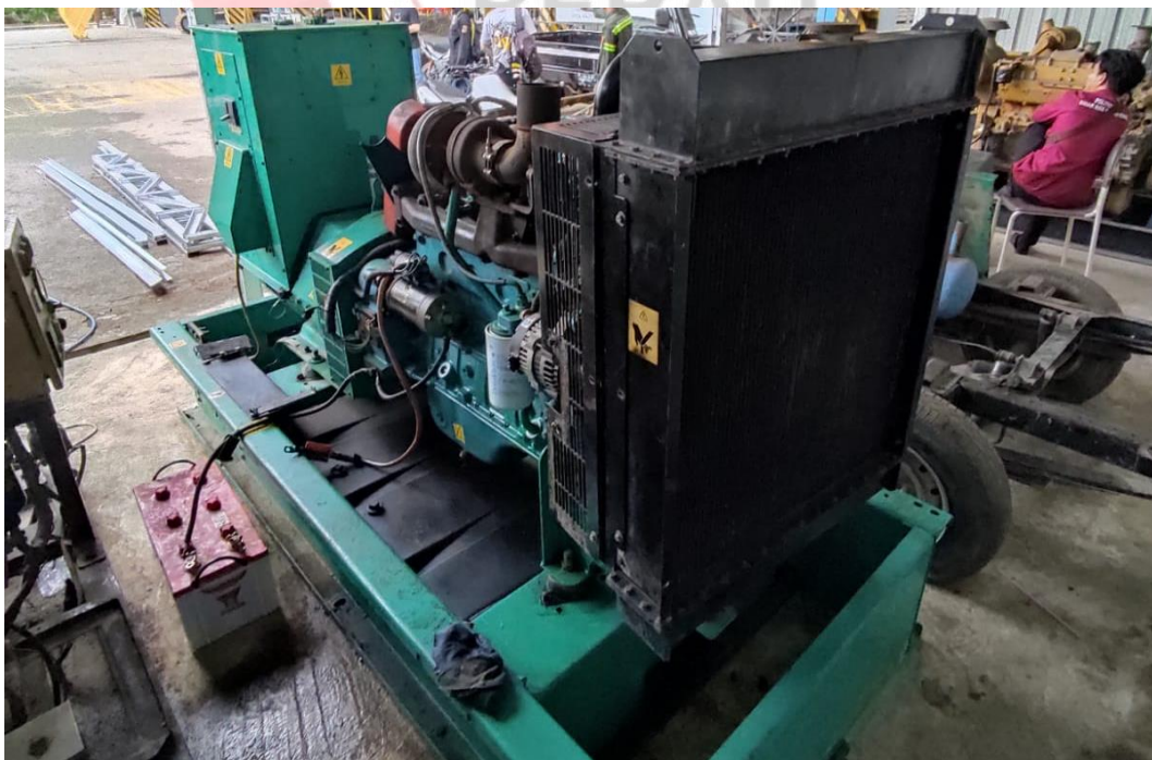
Gambar 10 Dokumentasi sesudah pemasangan radiator
