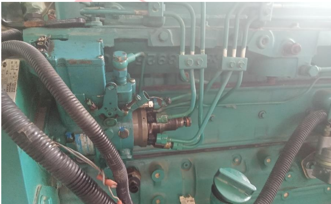
Gambar 8 Dokumentasi Sesudah Pemasangan FIP
