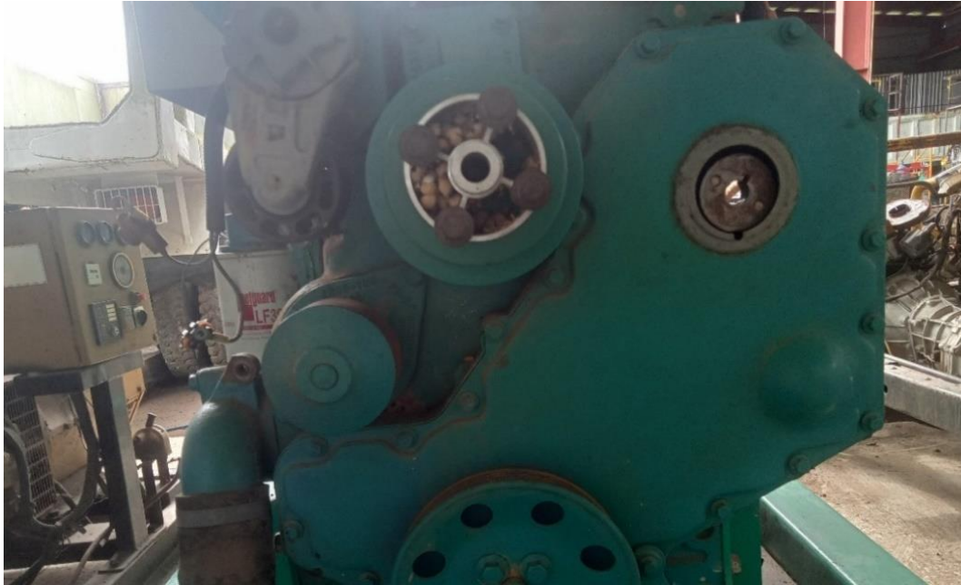
Gambar 20 Dokumentasi Sebelum Pemasangan V-Belt
