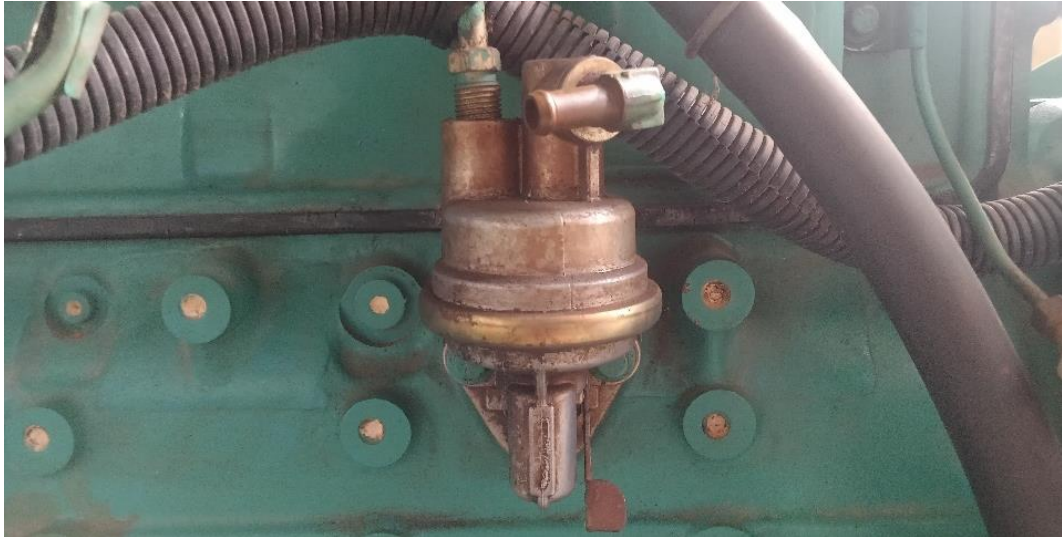
Gambar 11 Dokumentasi sebelum pemasangan feed pump
