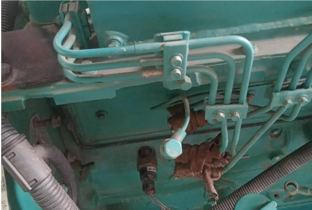
Gambar 7 Dokumentasi Sebelum Pemasangan FIP
