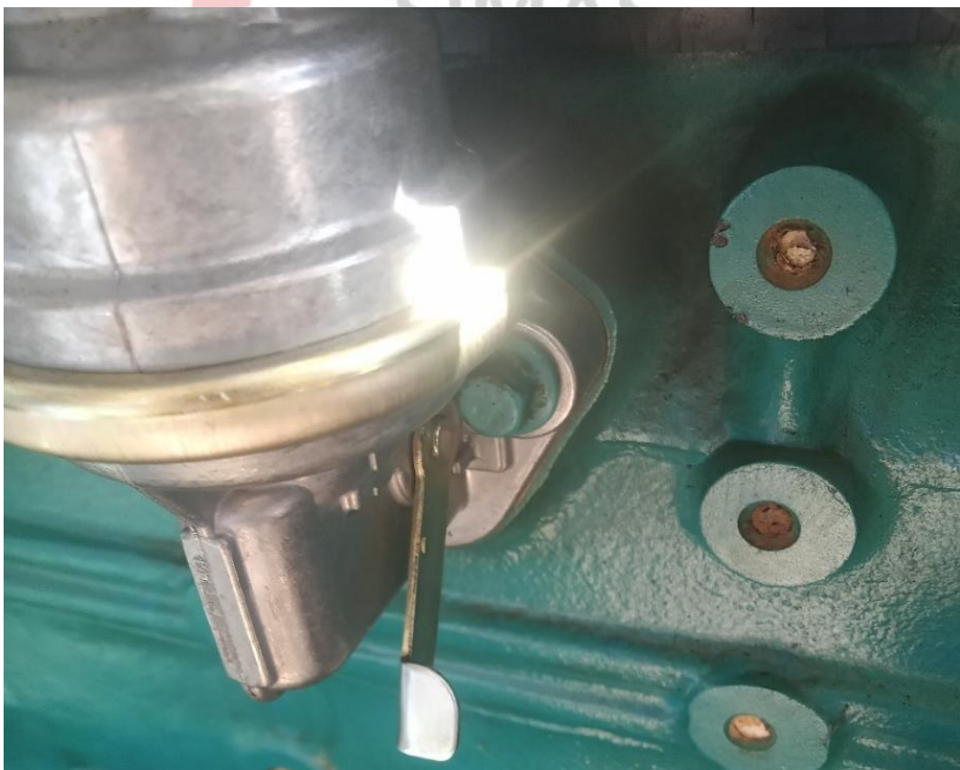
Gambar 12 Dokumentasi Sesudah Pemasangan Feed Pump
