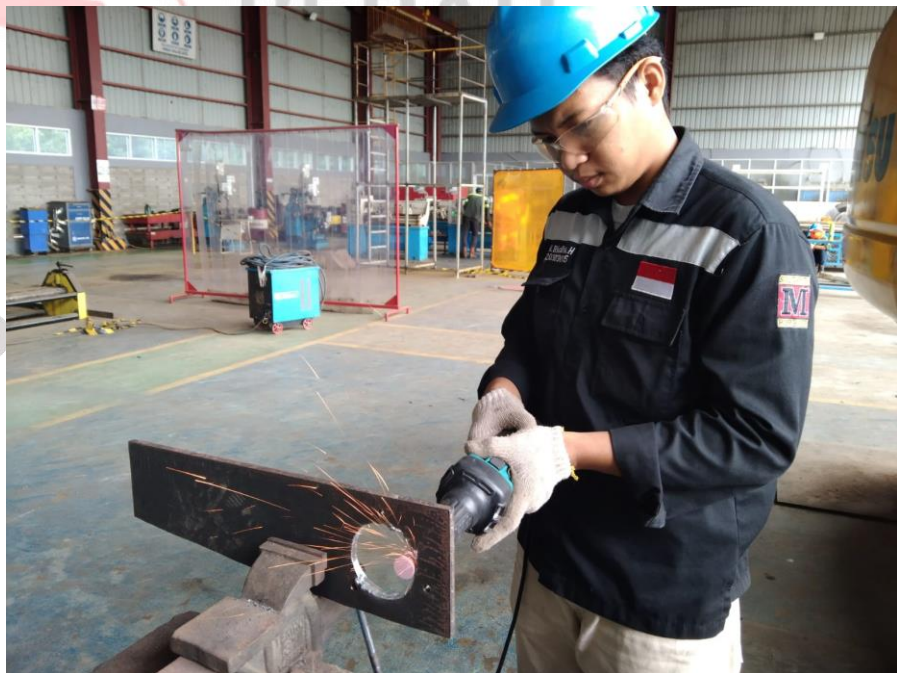
Penggerindaan plat dudukan roller
