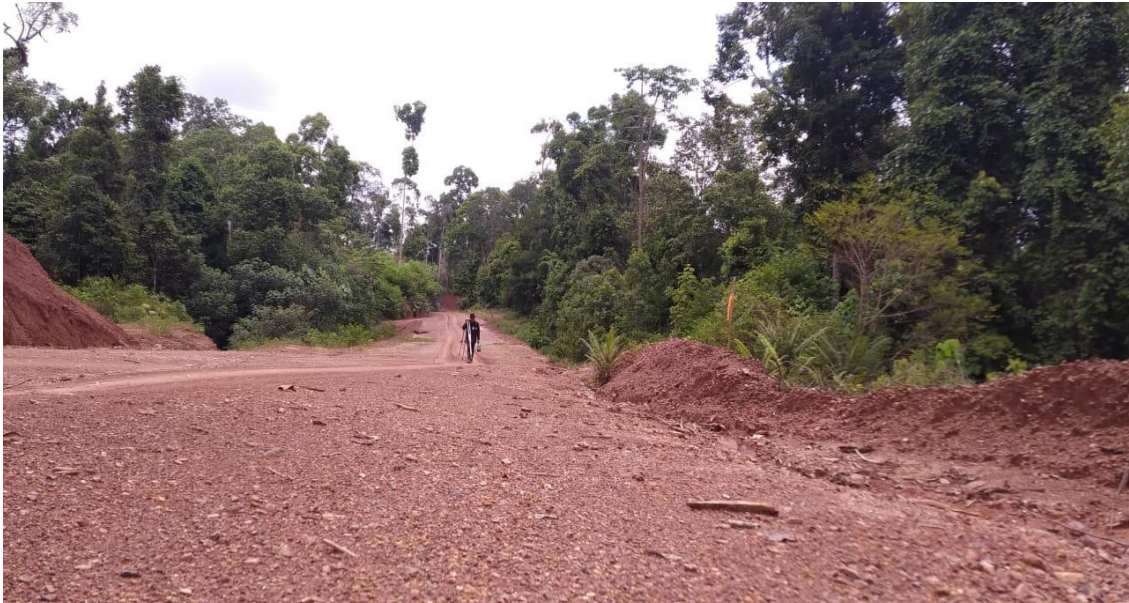
Gambar 1.1 Kondisi eksisting jalan
