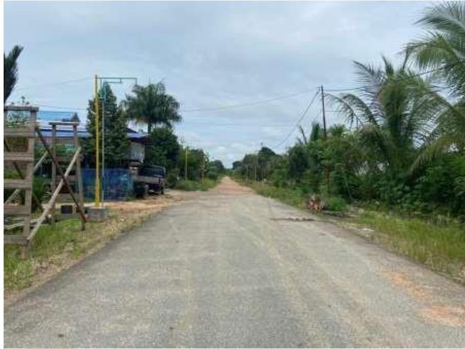
Gambar 1. 1 Kondisi Jalan Pandu dari STA 0+000 hingga STA 0+075
