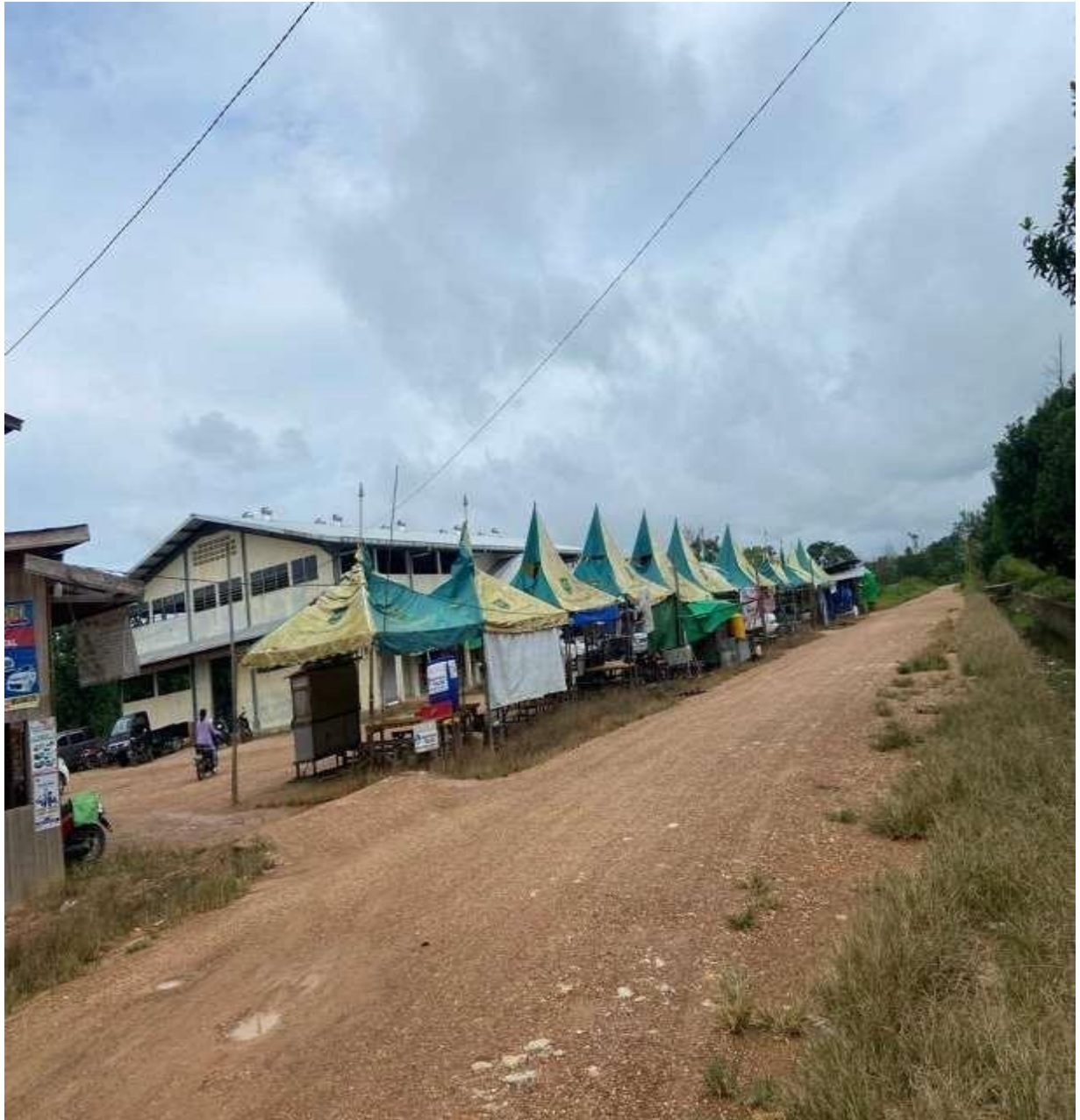
Lampiran 2 Dokumentasi Kondisi Jalan Didepan Pasar Senja Kampung Trans Bangun
